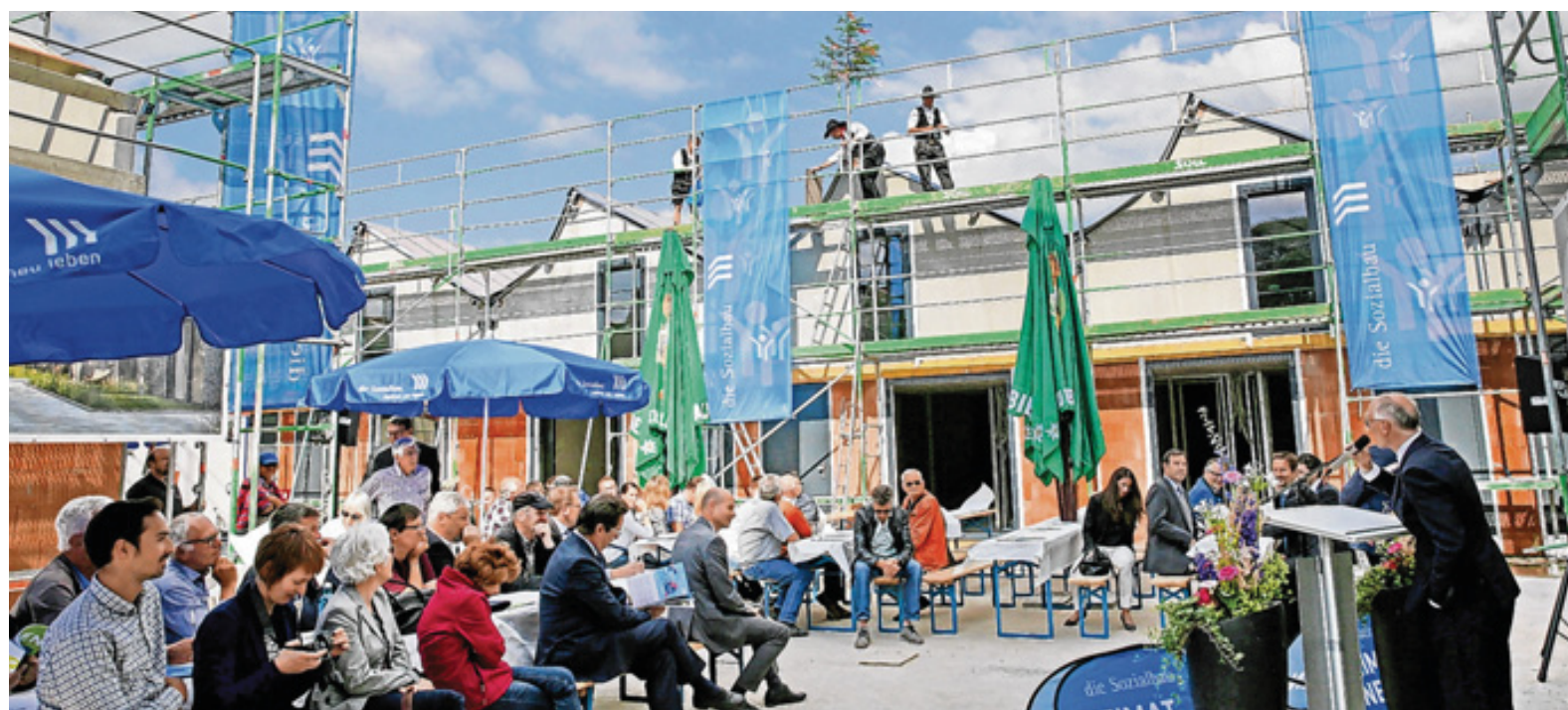
Richtfest wurde gefeiert für die künftigen Wohnungen in der Sheddachhalle an der Keselstraße.
