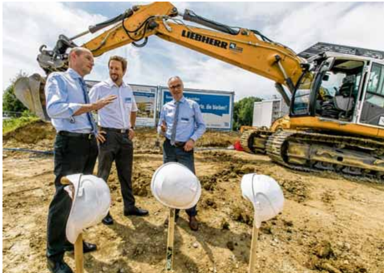
Oberbürgermeister Thomas Kiechle, Baureferent Tim Koemstedt und Sozialbau-Chef Herbert Singer (von links) fachsimplelten am Freitagmittag beim Spatenstich über die künftige Bebauung der letzten freien Fläche der Jakobwiese. Foto: Ralf Lienert
