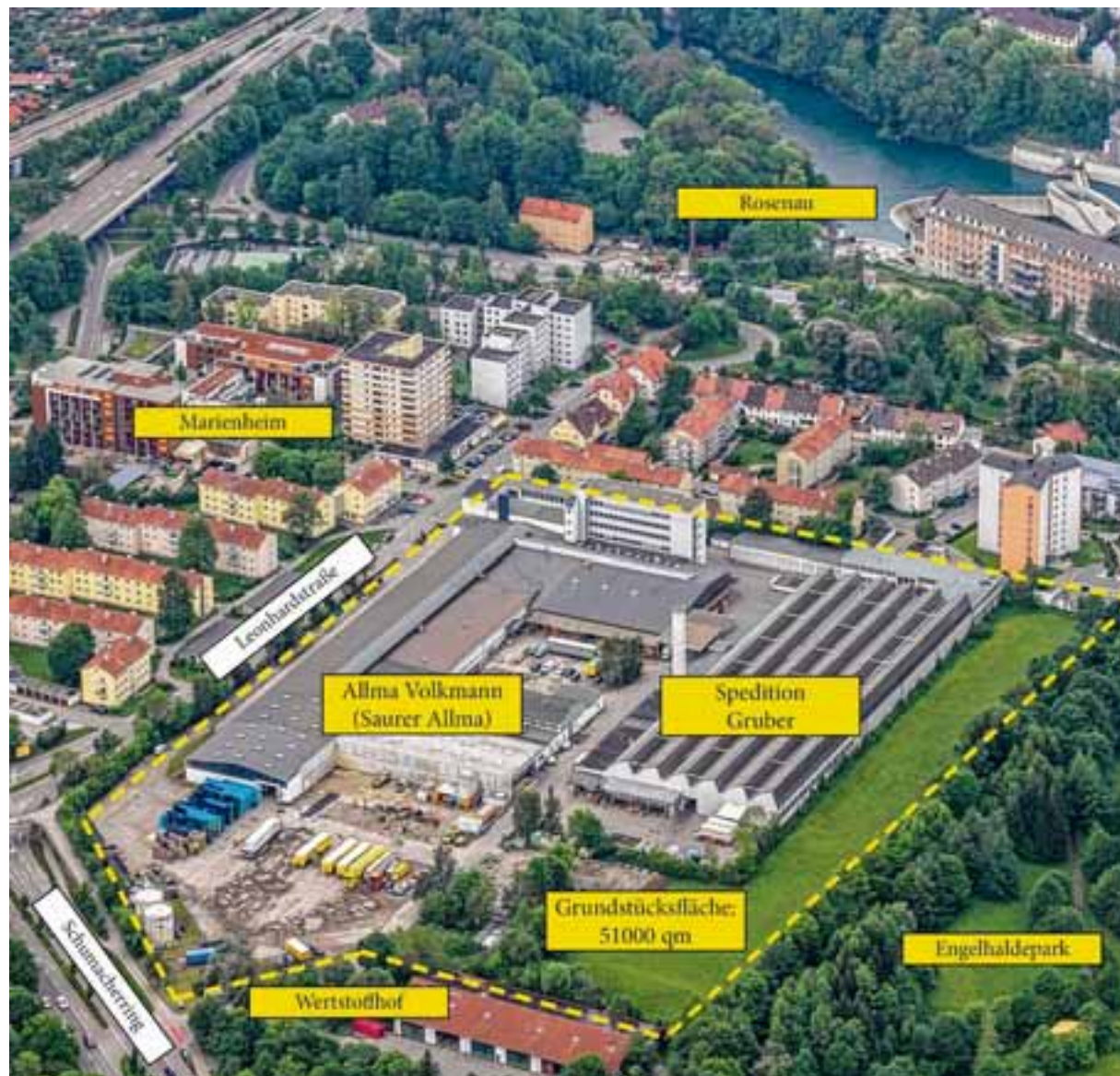
Das „Saurer-Allma-Gelände“ in der Leonhardstraße gehört jetzt der Sozialbau. Die Mietverträge für die Firmen dort laufen weiter. Vorstellen kann man künftig sich auf dem Areal am Schumacherring Gewerbe oder Wohnungen. Foto: Ralf Lienert
